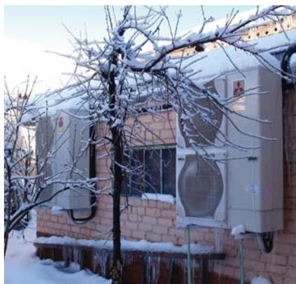
Отопление тепловыми насосами ZUBADAN Inverter
